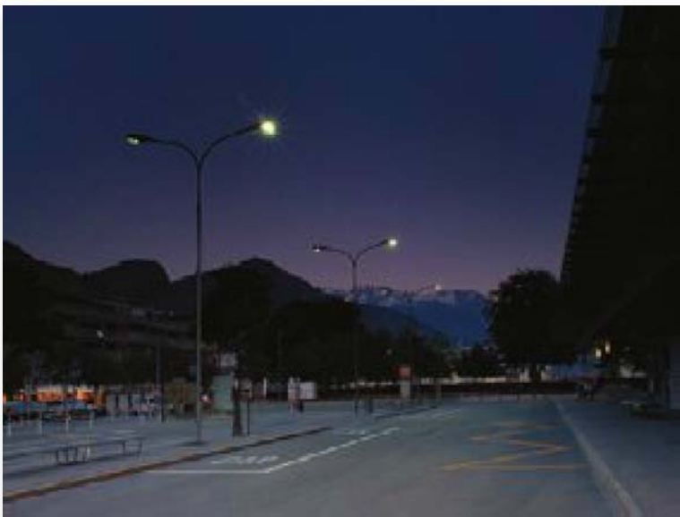
Bild 1 Mit LED-Leuchten kann das Licht exakter platziert werden als mit anderen Leuchten. Unerwünschte Beleuchtung ausserhalb der Strasse entsteht praktisch nicht.
